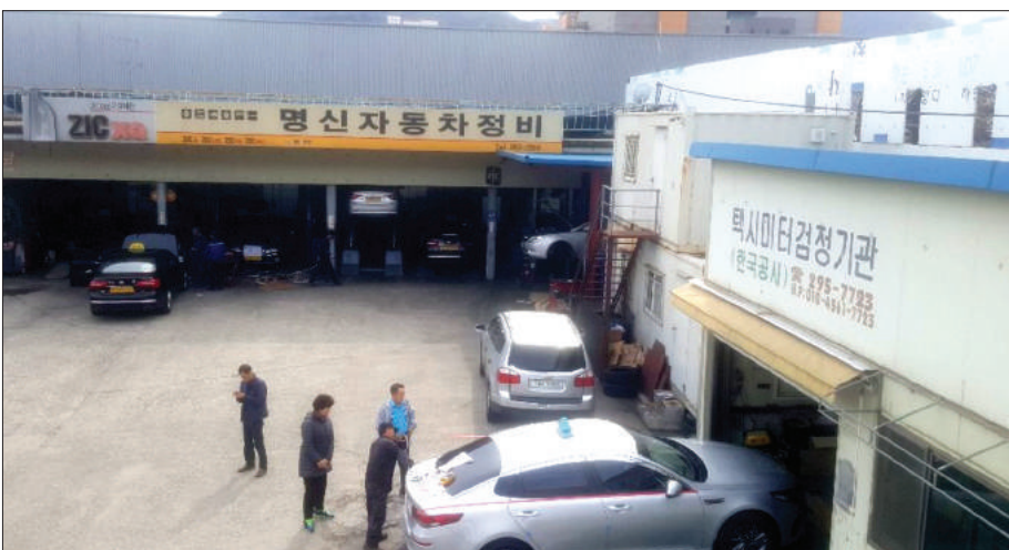
▲ 복지 충전소 내 정비업소 전경
